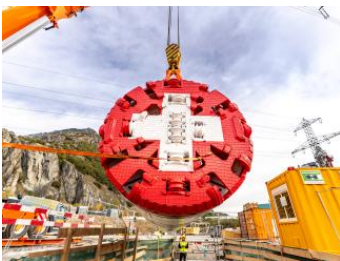
Infrastructure de réseau
