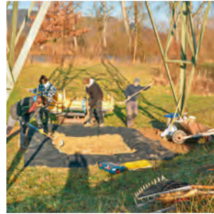
Bau eines Tümpels direkt unter einem Mast
