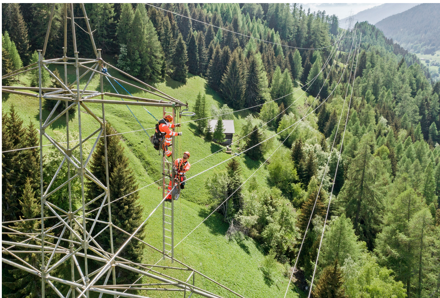
Rückbau 220-kV-Leitung Mörel – Ulrichen (VS)
