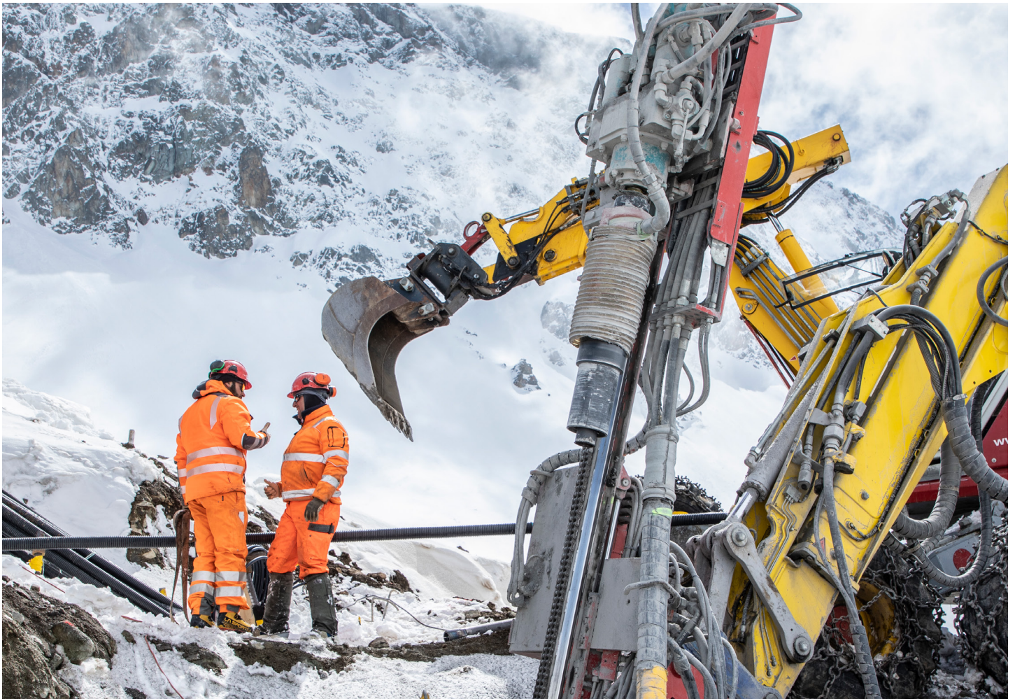
Erstellung Mastfundamente am Albula-Pass (GR)
