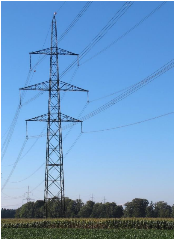
Bestehendes Mastbild mit Einfachtraggasse
