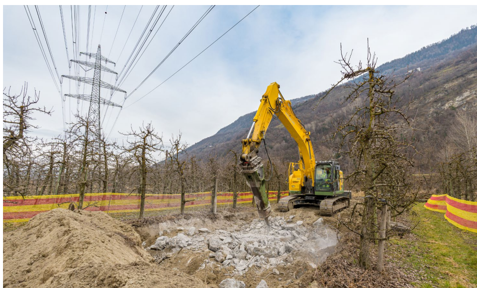
Démolition des fondations d'un ancien pylône
