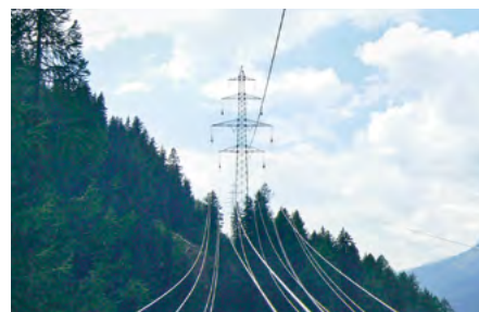
Die Leiterseile werden im Sommer eingezogen.
