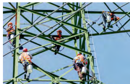
Mastanstrich: Die grüne Farbe schützt die Masten vor Korrosion.
