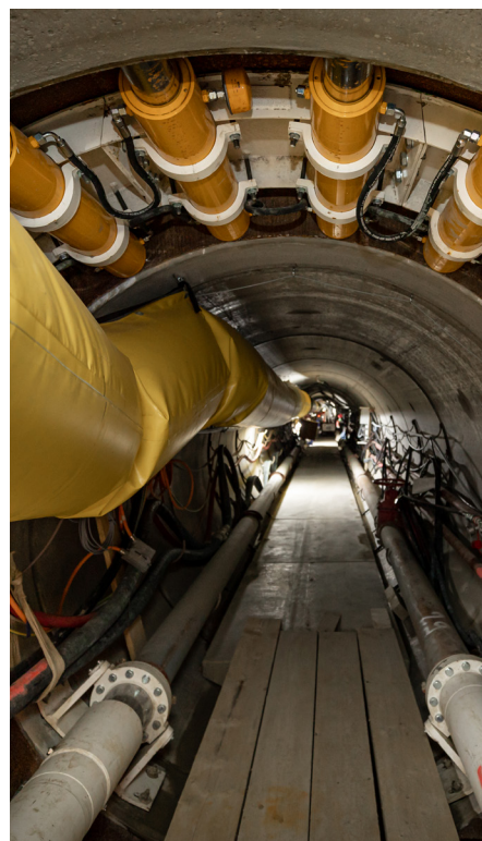
Vue de la galerie depuis le puits du Verney, avril 2021
