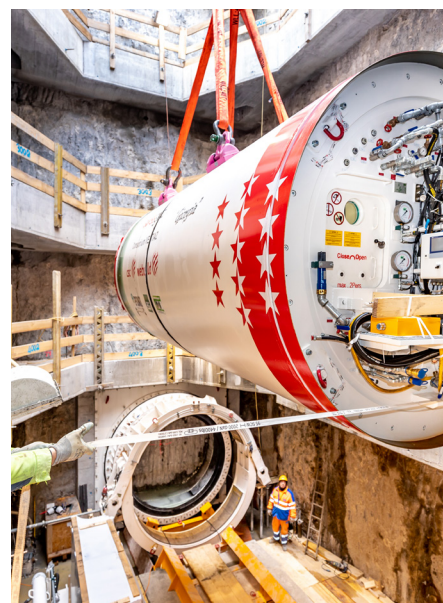
Descente du mini-tunnelier dans le puits du Verney, novembre 2020
