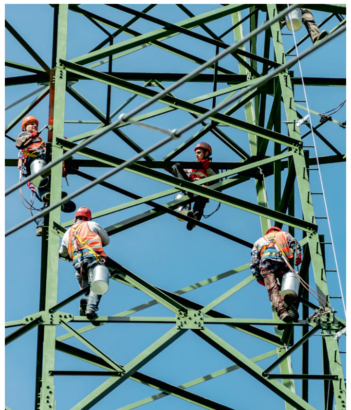
Travaux de peinture, mai 2017
