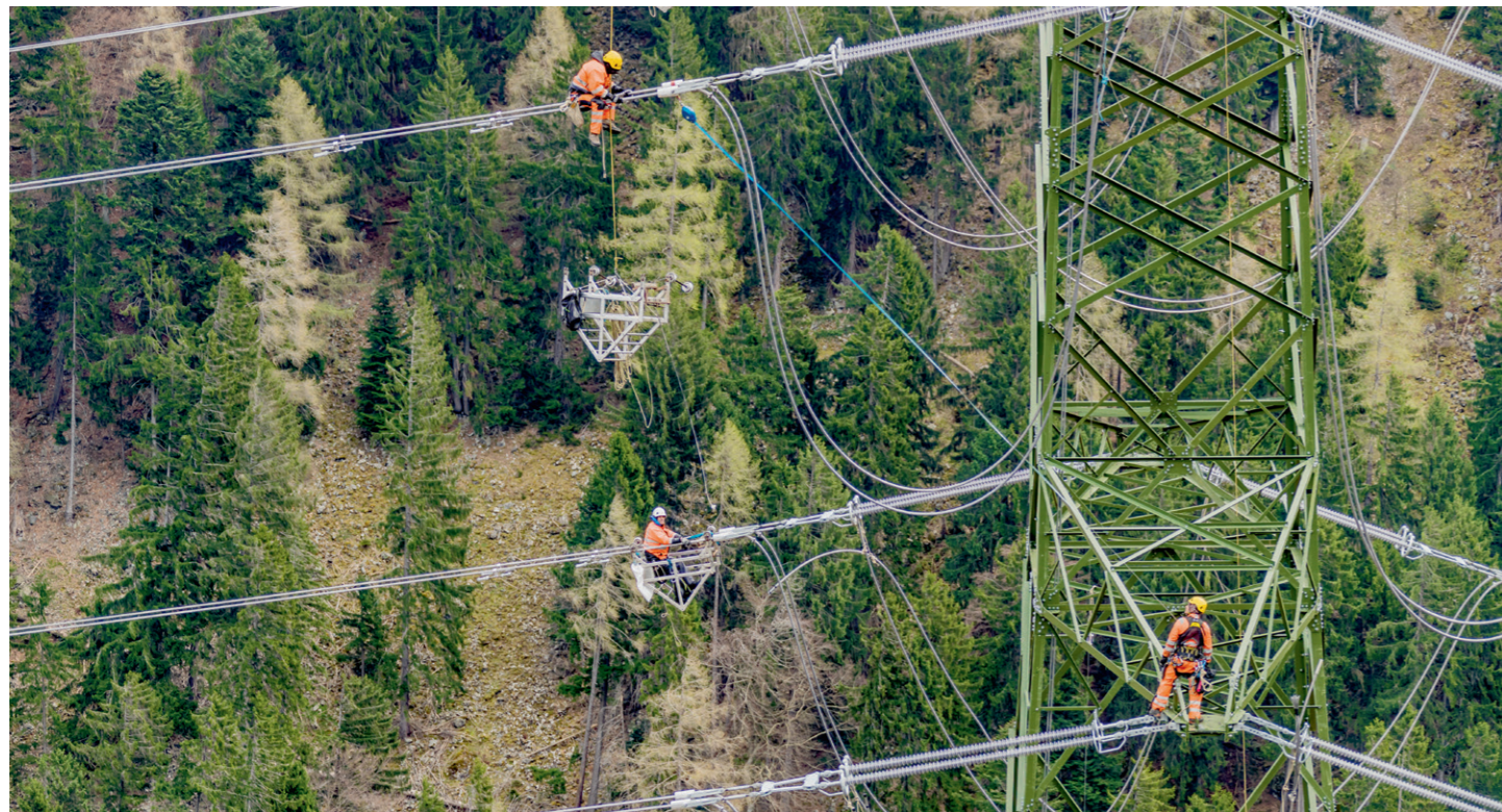
Contrôle des câbles, pylône 127, avril 2017
