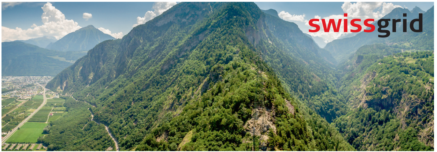
Panorama de la nouvelle ligne aérienne 380 kV Châtelard – La Bâtiâz, juin 2017
