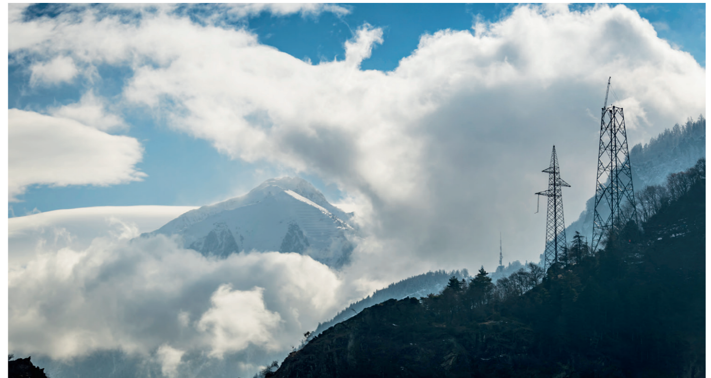
Nouveau pylône 128 en construction et ancien pylône en cours de démantèlement, février 2017
