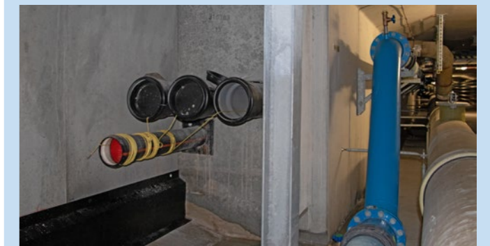
In beiden Tunnelröhren sind neben dem Werkleitungskanal bereits Leerrohre für die Kabel der Höchstspannungsleitung vorhanden.
