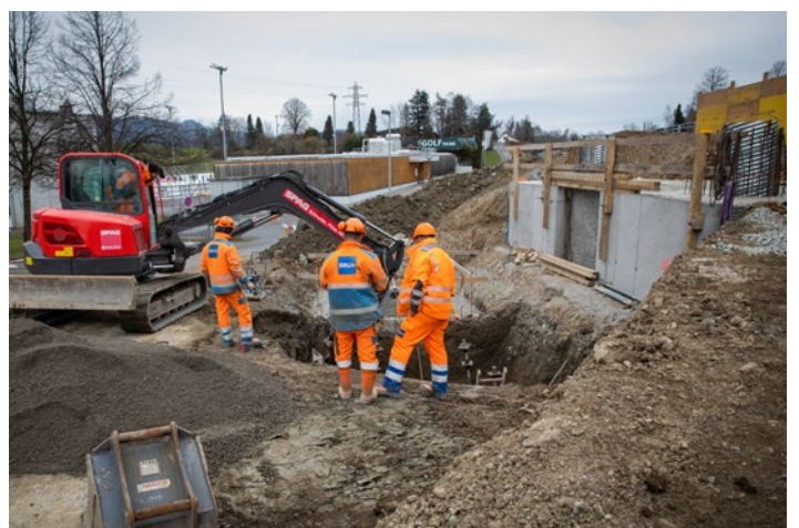
Zwischen Oktober 2022 und März 2023 hat Swissgrid die Fundamente für die sechs neuen Masten gebaut.
