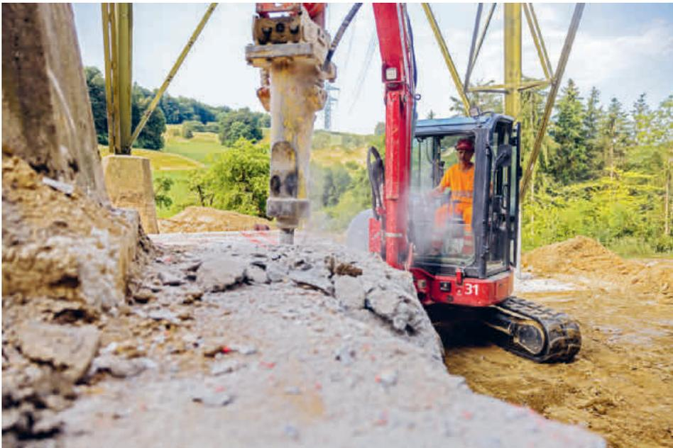
Bevor das neue, verstärkte Fundament der Masten erstellt werden konnte, musste der Beton der alten Fundamente teilweise weggespitzt werden. Um die bestehenden vier Fundamente eines Masten zu verstärken, werden ungefähr 7500 Kilogramm Stahl für die Armierung, 100 Kubikmeter Beton und rund 3 Wochen Arbeitszeit benötigt.
