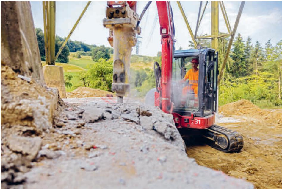
Avant de pouvoir réaliser les nouvelles fondations renforcées des pylônes, il a fallu retirer une partie du béton des anciennes fondations. Pour renforcer les quatre fondations existantes d'un pylône, il faut environ 7500 kilogrammes d'acier pour l'armature, 100 mètres cubes de béton et trois semaines de travail.
