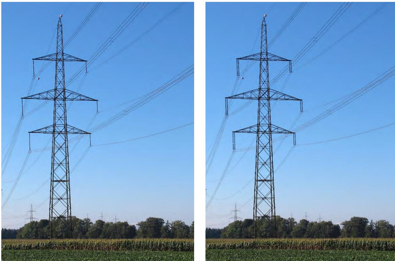
**Abb. 4** Bestehendes Mastbild mit Einfachtragglette (links), Mastbild mit Einbau Doppeltragglette (rechts).
