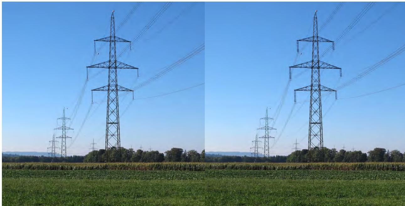
**Abb. 14** Umrüstung von Einfachtraggittern zu Doppeltraggittern (links: Bestand; rechts: Projekt).
