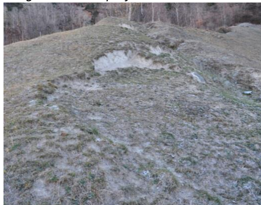
Niche de glissement superficiel
