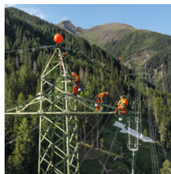
Für den Korrosionsschutz wurde der grüne Farbanstrich unter spektakulärem Einsatz der Freileitungsmonteure erneuert. Dadurch passen sich die Masten besser ins Landschaftsbild ein.
