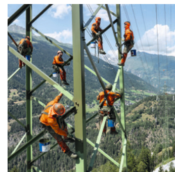
Für den Korrosionsschutz wurde der grüne Farbanstrich unter spektakulärem Einsatz der Freileitungsmonteure erneuert. Dadurch passen sich die Masten besser ins Landschaftsbild ein.
