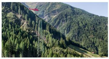
In luftiger Höhe werden die Strommasten für die zukünftige Höchstspannungsleitung montiert. An den meisten Maststandorten sind die Montagearbeiten bereits weit fortgeschritten.
