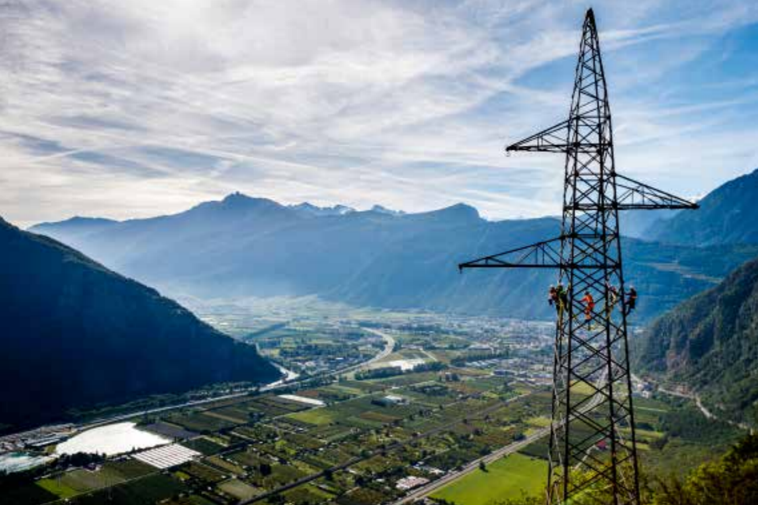
Arbeiten hoch über dem Rhône-Tal: Auf den drei Ausleger-Ebenen muss jeweils noch ein Ausleger montiert werden. Als Nächstes wird der Mast grün angestrichen. Die Farbedient dem Korrosionsschutz
