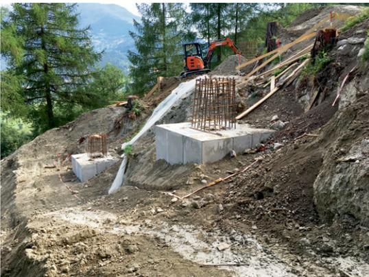
Die Fundamentschäfte wurden betoniert und mit Erde aufgefüllt.
