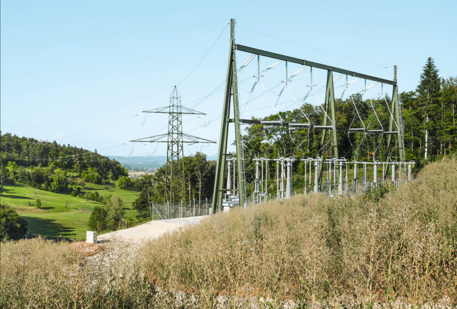
Struttura di transizione a Riniken (AG) nel progetto di rete Beznau–Birr
