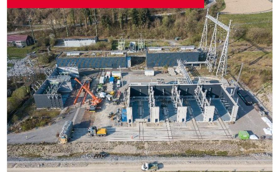
Erfolgreiche Erneuerung von Unterwerken: grösste gasisolierte Schaltanlage der Schweiz in Innertkirchen benötigt deutlich weniger Fläche als Freiluftschaltanlage.
