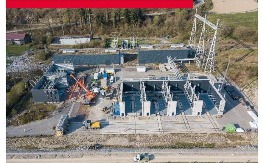
Rénovation réussie des sous-stations: le plus grand poste de couplage isolé au gaz de Suisse à Innertkirchen nécessite bien moins de surface qu'un poste de couplage en plein air.
