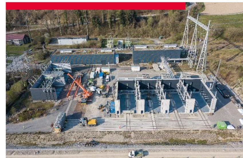
Successo nel rinnovamento delle sottostazioni: il più grande impianto di smistamento isolato a gas della Svizzera a Innertkirchen, richiede una superficie molto inferiore rispetto a un impianto di smistamento aereo.
