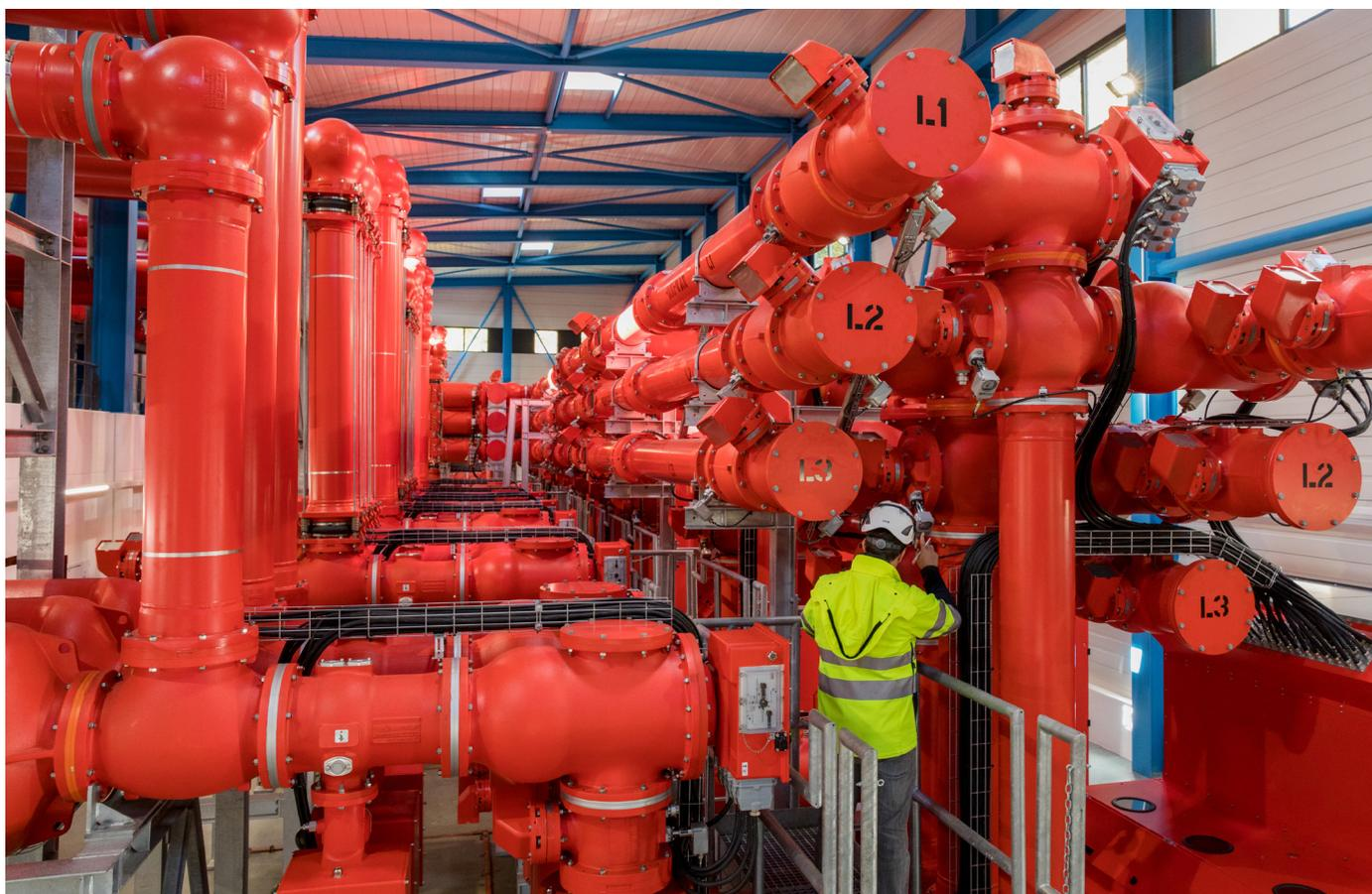
Verifica della pressione di una camera dell'impianto di smistamento 220 kV isolato a gas a Romanel
