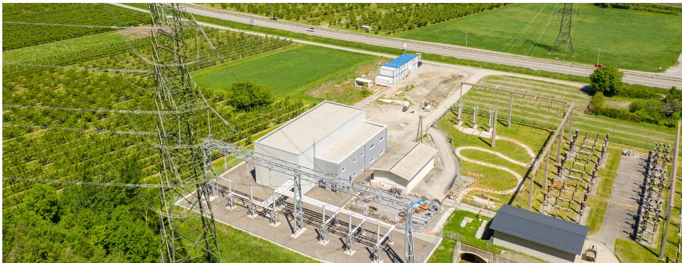
Esempio di un impianto di smistamento isolato a gas: grazie al design compatto, l'area occupata può essere ridotta di circa un terzo.
