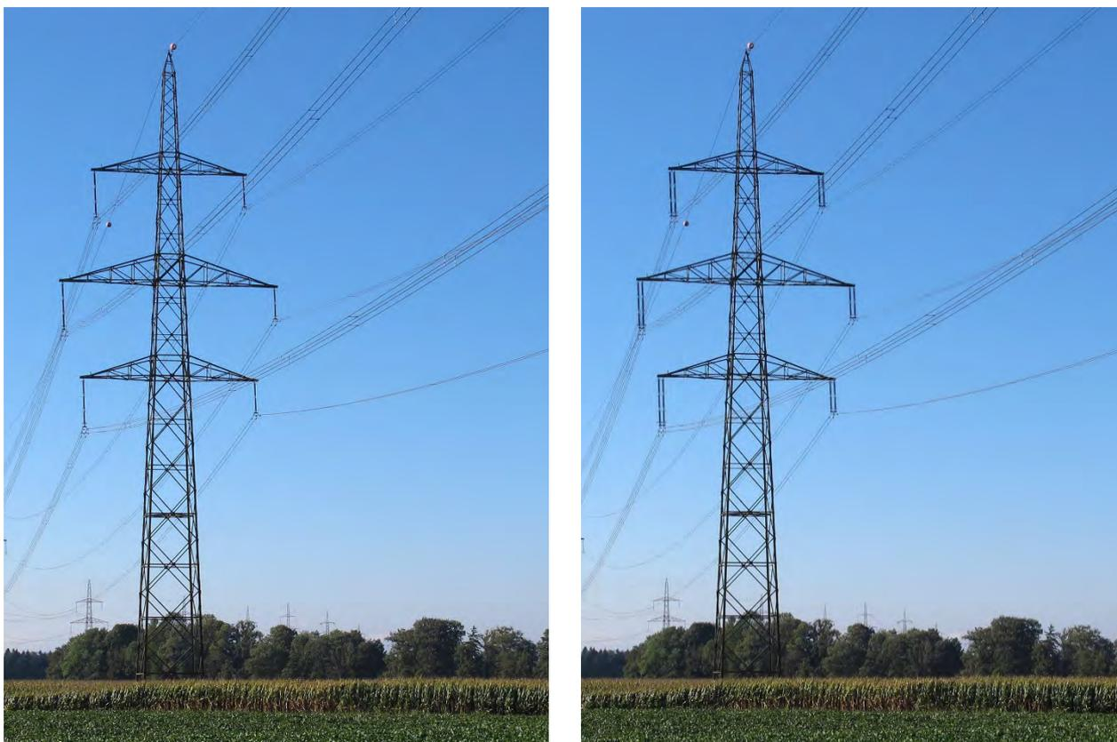
**Fig. 4** Silhouette de pylône existant avec chaînes de suspension simples (à gauche), silhouette de pylône après montage de chaînes de suspension doubles (à droite)
