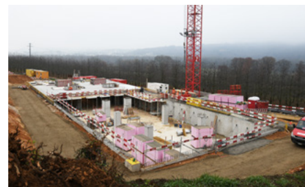
Weit fortgeschrittene Tiefbauarbeiten beim Übergangsbauwerk Süd
