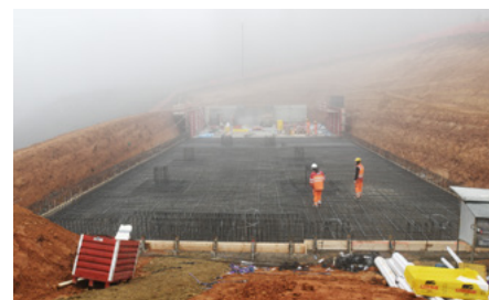
Betonierung der Bodenplatte beim Übergangsbauwerks Nord
