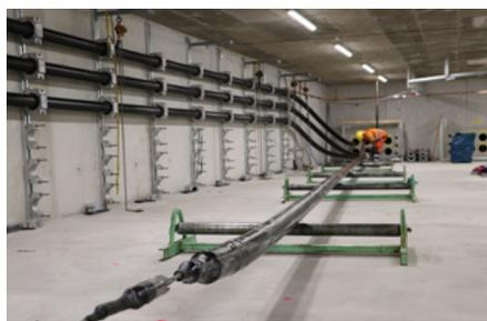
Beim Übergangsbauwerk Süd wird das Kabel nach 1,3 Kilometer mittels Zugmaschine wieder aus dem Kabelrohrblock gezogen.
