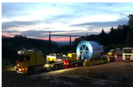
Transport einer Kabelrolle am frühen Morgen von Brugg via Villnachern, Umiken und Hafan zum Übergangsbauwerk Nord, wo das Kabel in den Kabelrohrblock eingezogen wird.
