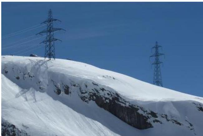
**Abb. 43** Mast Nr. 55 (links) und 54 (rechts). Mast Nr. 55 soll um 6m erhöht werden.
