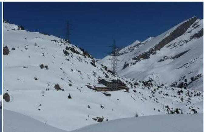
**Abb. 44** Mast Nr. 56 (rechts) und Nr. 57 (links), Erhöhung um je 6m.
