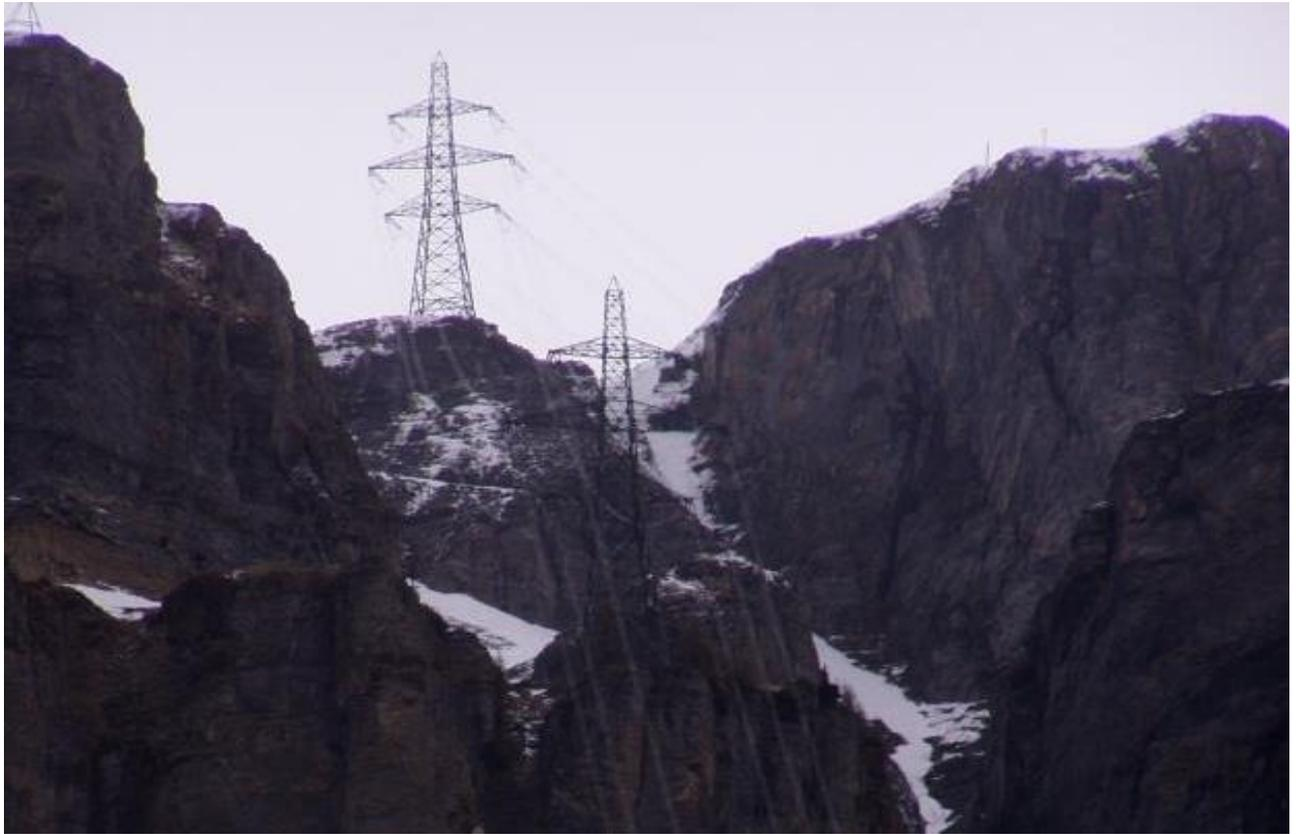
**Abb. 42** Mast Nr. 41 (vorne) und 42 (hinten). Erhöhung Mast Nr. 41 um 2m.
