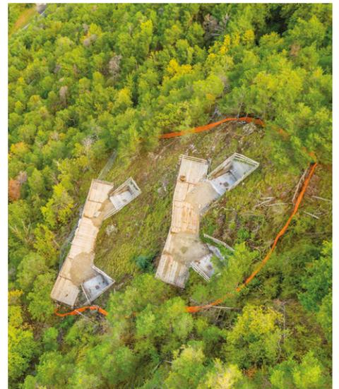
Le pylône 140 se situe dans une très forte pente, ce qui a nécessité l'héliportage et la mise en place de deux plateformes provisoires solidement fixées contre le rocher. Ces équipements ont été utiles pour les machines d'excavation, l'entreposage des déblais et pour le stockage des éléments du pylône.
