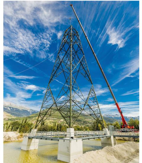
Le pylône 143 est implanté dans un bassin de décantation d'une gravière à St-Léonard. Si la construction des fondations a nécessité la vidange du bassin, le montage du pylône s'est effectué au début septembre, bassin plein.
