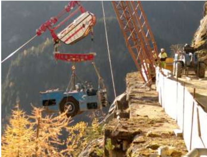
Abb. 16: Foto Exemplarische Materialseilbahn (Quelle: www.nigg-seilbahnen.ch/referenzen/sanierung-wasserschloss )
