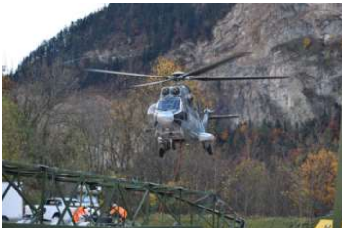
Abb. 17: Foto Exemplarischer Transport mit dem Helikopter (Quelle: https://www.landbote.ch/region/winterthur/toesstaler-firma-setzt-masten-in-felswand/story )
