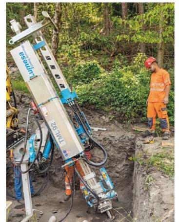
Der Schachtboden des Mastfundamentes wird betoniert und die untersten Stahlelemente der Masten im Beton verankert. Zur Verstärkung und Stabilisierung werden die Fundamente mit metallenen Pfählen im Boden verankert.
