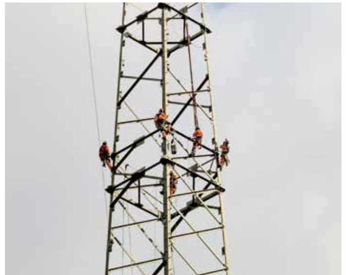
Démontage du pylône 101, ligne 220 kV, Finhaut. Octobre 2016
