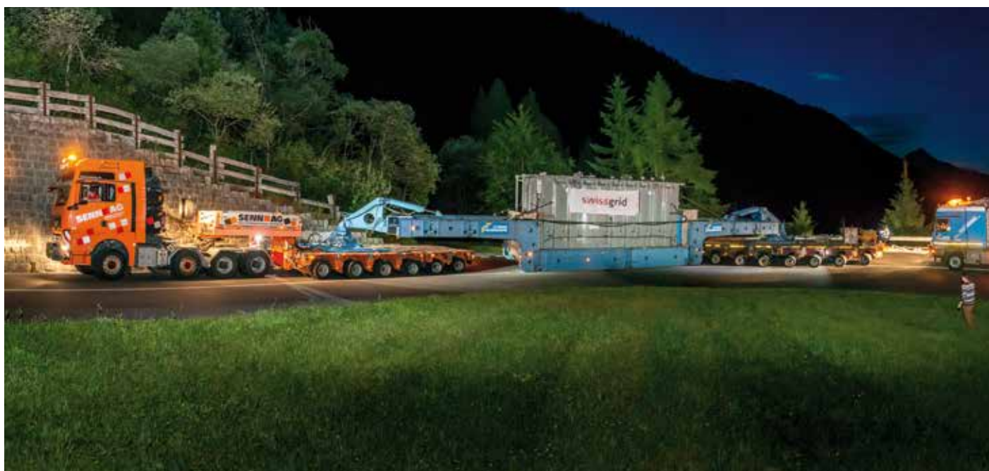
Transport du transformateur du poste de Châtelard. Juillet 2016
