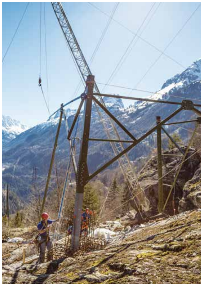
Montage du pylône 110, ligne 380 kV, Finhaut. Avril 2016
