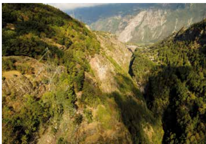
Tirage des câbles au pylône 127, ligne 380 kV, Salvan. Octobre 2016
