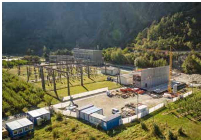
Construction du poste de La Bâtiaz. Octobre 2016
