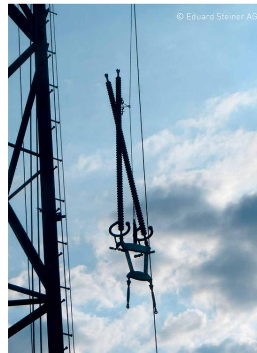
**Légère mais forte:** La chaîne d'isolateurs 380 kV de PFISTERER est hissée à l'aide d'un treuil avant son montage sur la flèche du pylône. C'est là que les avantages des isolateurs font la différence: grâce à la technologie en silicone, plus légers que les isolateurs classiques tout en étant extrêmement robustes.
