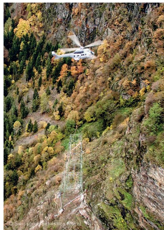
**Dans les airs:** Les étages de pylônes pré-montés ont été transportés par hélicoptère gros porteur en octobre 2015 pour la construction du pylône 124. Ces étages ont été posés sur le pylône, puis fixés par les monteurs. La même procédure a été réalisée pour cinq autres pylônes situés sur des emplacements difficiles.
