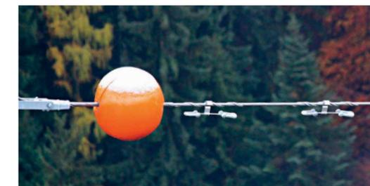
**La qualité du montage favorise la sécurité de fonctionnement:** La preuve en est faite par les chaînes d'amarrages 380 kV de PFISTERER, installées ici sur le pylône 124. Grâce à une conception intelligente des armatures, les anneaux de protection se bloquent automatiquement dans la bonne position lors du montage, ainsi leur fonction de protection est garantie sans alignement manuel.
