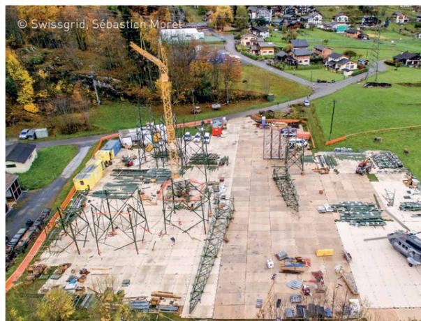
**Préparation avant le vol:** À Salvan sur une place de pré-assemblage. L'entreprise de montage prépare au moyen d'une grue les étages des pylônes avant que l'hélicoptère les transporte sur site.
