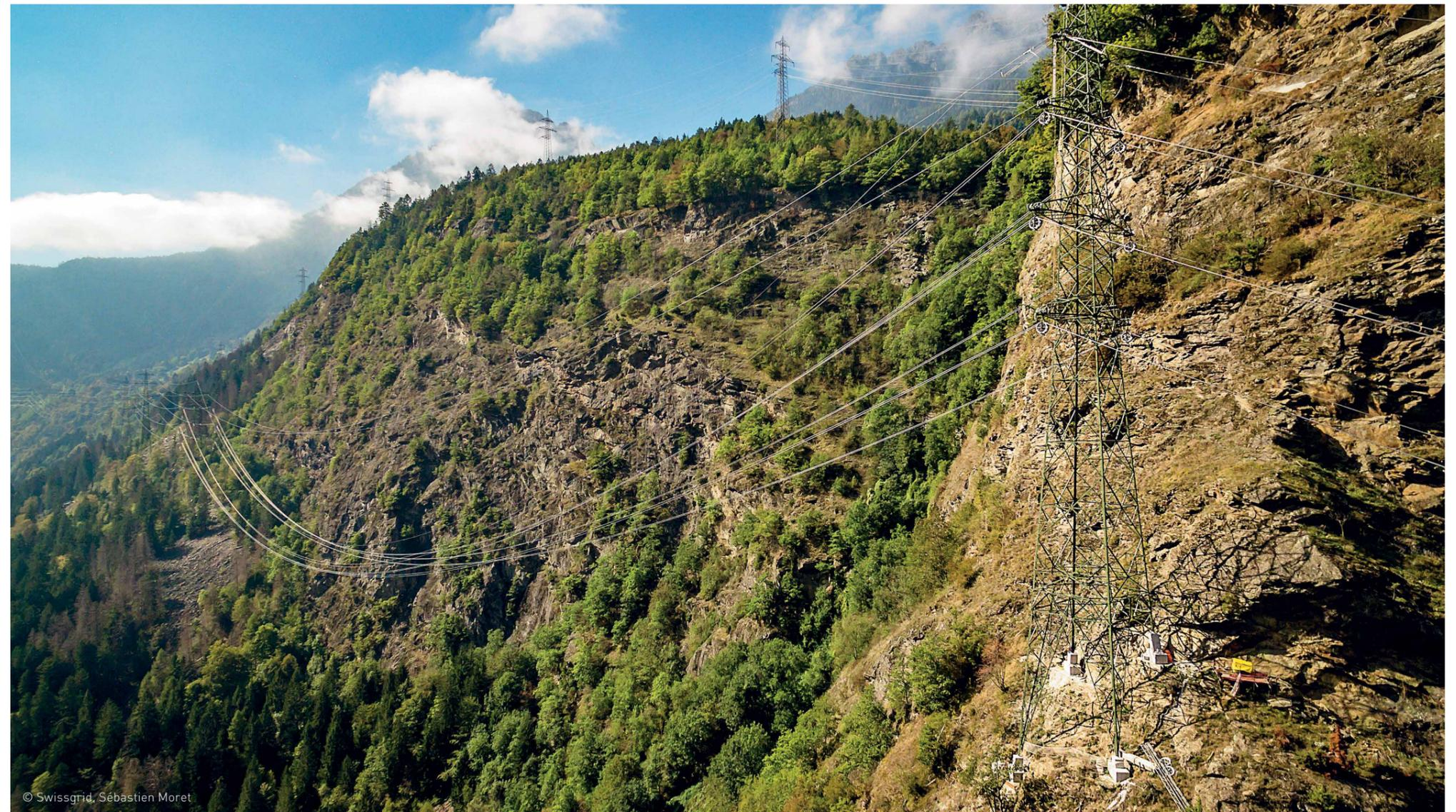
À pic au-dessus des gorges: En octobre 2016 un tronçon de la nouvelle ligne 380 kV de Swissgrid après le tirage des cordes – au premier plan à droite, le pylône 124. Son emplacement compte parmi les plus difficiles d'accès, il se situe en effet sur une paroi rocheuse presque verticale au-dessus des gorges du Trient.
