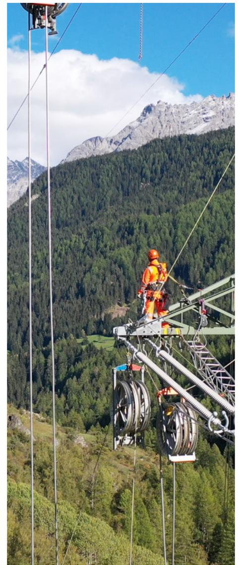
Nach dem Bau der Masten wurden die Leiterseile eingezogen.
