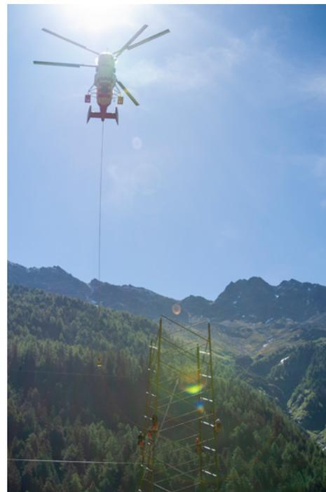
Mithilfe des Schwerlasthelikopters Kamov konnten bis zu 12 Masten an einem Tag demontiert werden.
