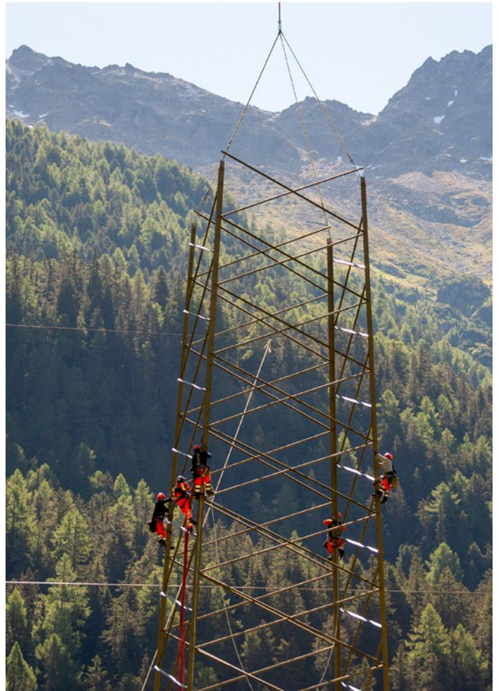
In schwindelerregender Höhe demontieren die Monteure einen Mast.
