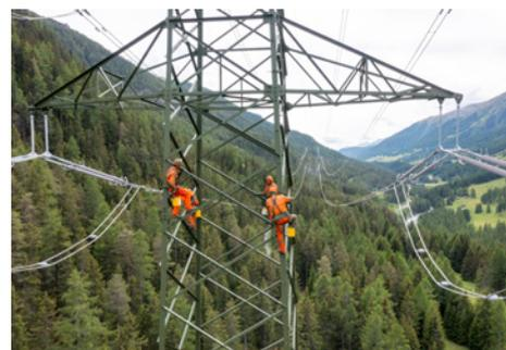
Insgesamt 30 Tonnen grüner Schutzanstrich werden von Hand mit Pinsel aufgetragen. Die grüne Farbe tarnt die Masten in der Landschaft und schützt diese vor Korrosion.
