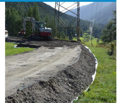
Das Vlies schützte den Boden während der Bauarbeiten. Il vliès ha protegi il terren durant las lavurs da construcziun.
