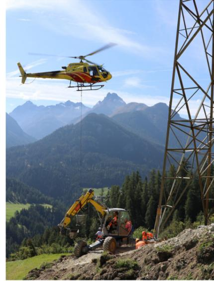
Nach Erhalt der Bewilligung 2016 starten im folgenden Jahr die Bauarbeiten. Bei allen Masten werden die Fundamente und die Betonsockel saniert.
