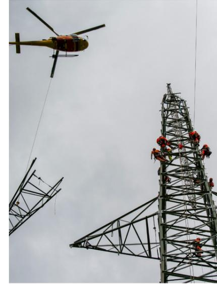
Aus statischen Gründen werden 93 Masten ersetzt. Zwei werden neu gebaut, 32 verstärkt. Nach dem Bau werden die neuen Leiterseile eingezogen. Am 11. November 2022 geht die ausgebaute Leitung in Betrieb. Es folgen die Malerarbeiten für den grünen Schutzanstrich.
