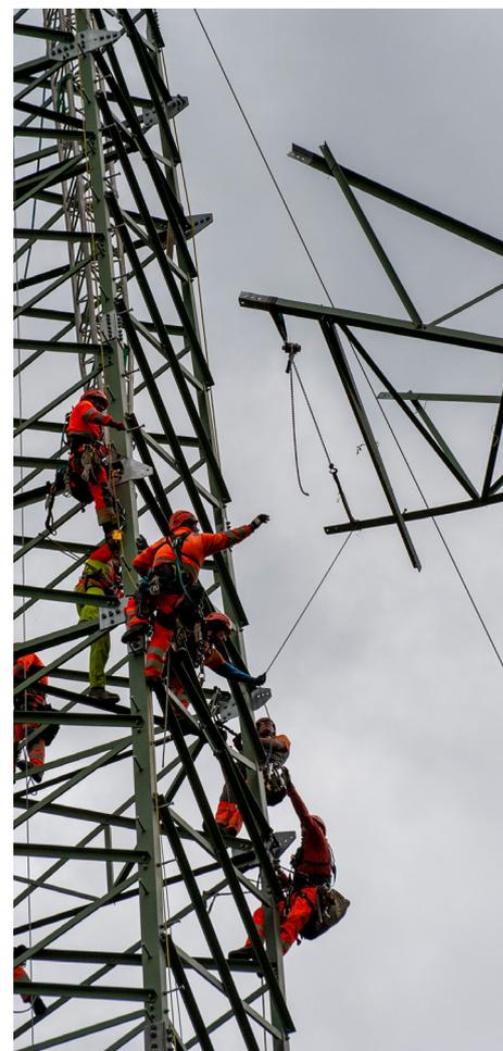
Bei der Montage eines Masts ist Fingerspitzengefühl notwendig. Hier werden gerade mithilfe eines Helikopters die Ausleger montiert, an deren Spitze später die Isolatorenketten mit den Leiterseilen hängen.
