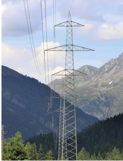
Zum Zeitpunkt des Baus muss die Leitung noch viel weniger Strom transportieren als heute. Zwischen La Punt und Zernez werden die Strommasten deshalb nur auf einer Seite mit einer Leitung belegt.
