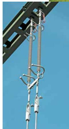
**Plus für Montage & Betrieb:** Mit 220-kV-Komplettketten von PFISTERER werden die an der Schaltanlage ein- und ausgehenden Leitungen abgespannt (Montage der Ketten im kleinen Bild oben, fertig installierte Ketten in Bildern darunter). Die kompakte Ketten-Bauform ermöglichen schlanke Verbundisolatoren mit kombiniertem Korona- und Lichtbogenschutz. Dank HTV-Silikongummischirmmantel sind die Isolatoren viel leichter und bruchresistenter als konventionelle Isolatoren.
