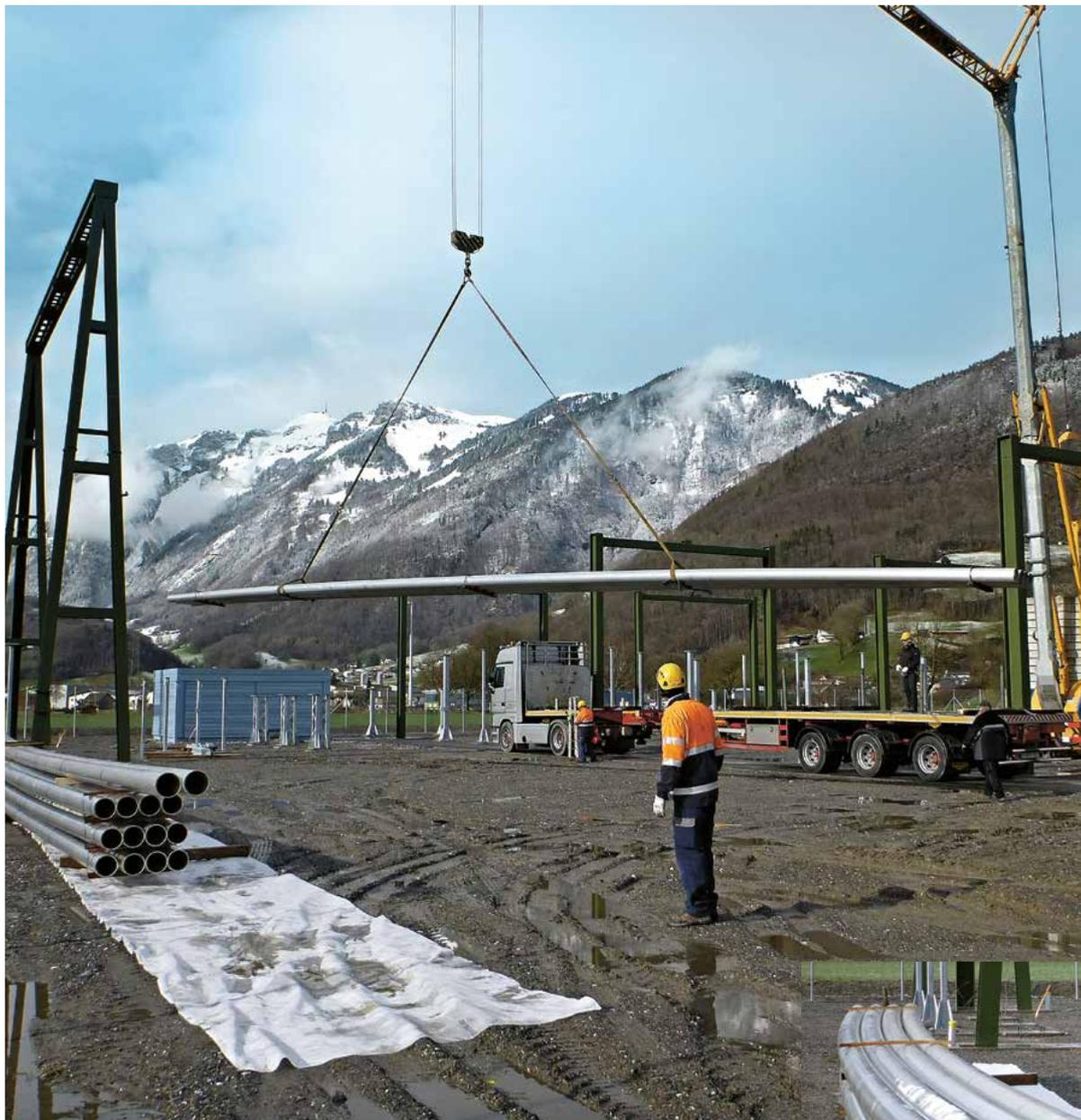
**Dynamiken durchdacht:** Die Sammelschienen-Rohrleiter wurden gemäß PFISTERER Auslegung vorgebogen angeliefert und mit dem Bogen gen Himmel montiert. Dadurch wird die Rohrdurchbiegung unter Eigengewicht und Eislast Richtung Boden teilweise kompensiert. Bei der Rohrmontage wurden Seile integriert. Als ungefesselte Zusatzmassen im Rohrinneren dämpfen sie windinduzierte Rohrschwingungen, um Ermüdungsbrüche am Leiter und Beschädigungen an Stützern und Geräten abzuwehren.
